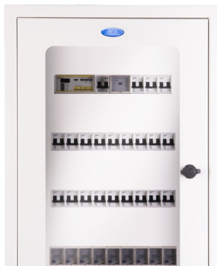
Quadro de Energia Elétrica - Sistema IT Médico
